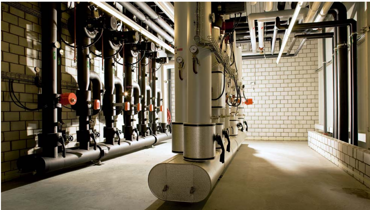
Oben die Wärme- und Kälteverteilungsanlage des Gebäudes. Das helle System verteilt die Kälte, das dunkle die Wärme. Auf dem Foto ganz rechts sind die beiden mit Holzpellets betriebenen Brennöfen zu sehen – die grössten ihrer Art, die bisher konstruiert wurden.
